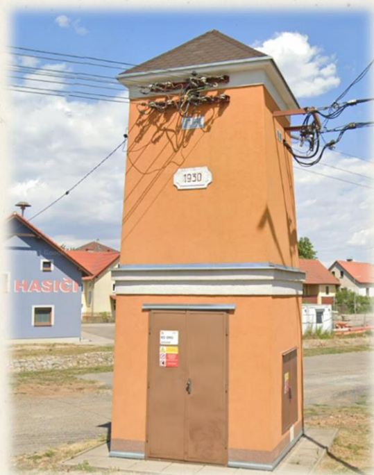
Transformační stanice v současnosti
